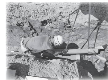
水道管布設風景
