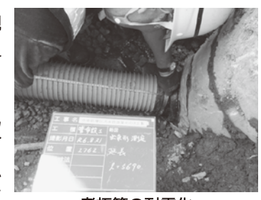
老朽管の耐震化
