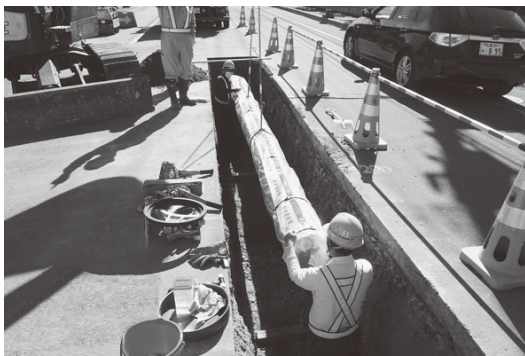
水道管耐震化工事
