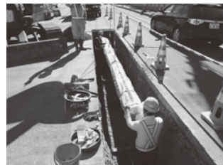
耐震化工事の施工状況
