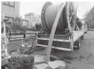
耐震化工事の施工状況
