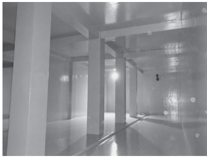
配水池内部の様子
