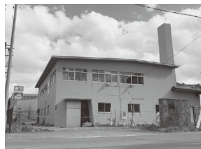
勝納汚水中継ポンプ場の外観
