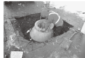
マンホール蓋改築
