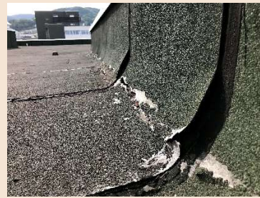
屋上防水層の破断
