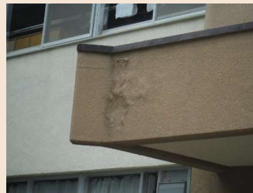
外壁塗装の膨れ
