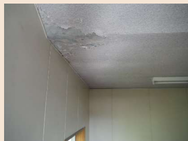
天井塗装剥落
