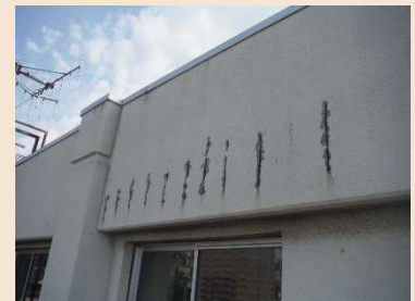
外壁の鉄筋露出
