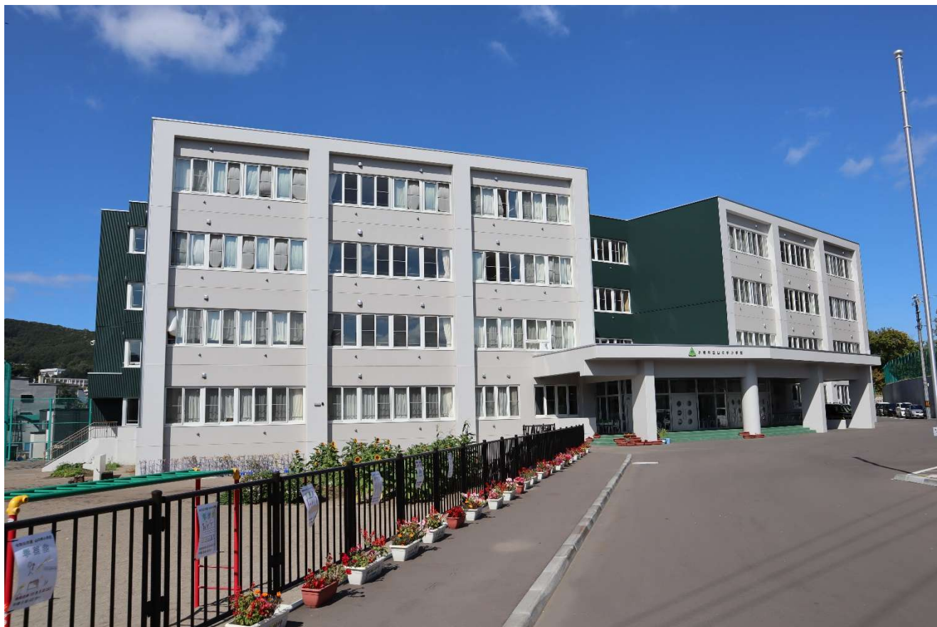
山の手小学校新築工事（平成 29 年度竣工）
