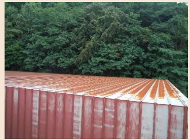
屋根の塗装劣化
