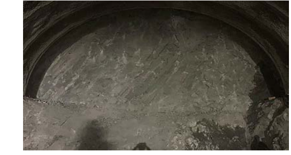
後志トンネル(塩谷) トンネル切羽状況
