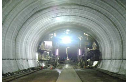
昆布トンネル(桂台) FILM施工状況
