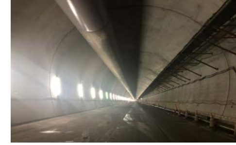
野田追トンネル(南)他 覆工コンクリート完了状況
