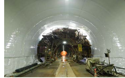
昆布トンネル(桂台)他 FILM施工状況
