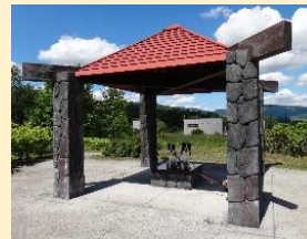
鋼製＋ウレタン樹脂＋樹脂モルタル擬石
