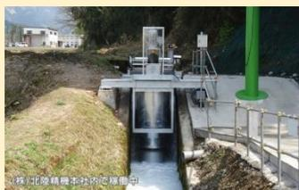
農業用水路などに設置できる100Kw以下のマイクロ水力発電機「パワーアルキメデス」を株式会社北陸精機の北海道エリア総代理店として、取り扱っています。
