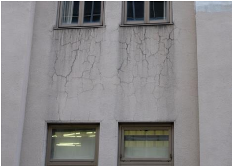
外壁のひび割れ
