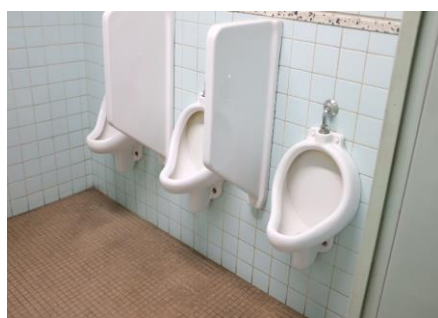
障害者に対応していないトイレ
