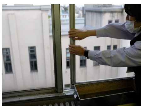
建物の歪みにより窓が開かない
