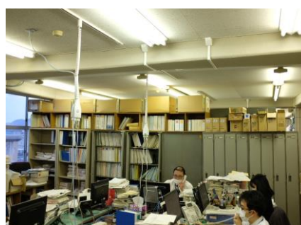
床の歪みにより、書類ロッカーが開きにくい
