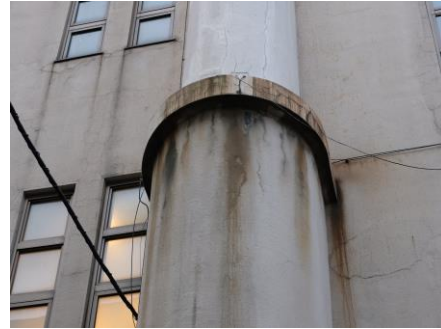
煙突部のひび割れ
