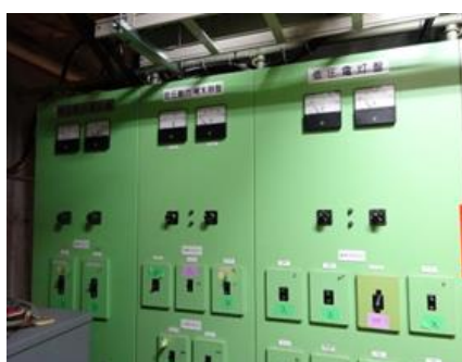
平成28（2016）年に受変電設備（機器）改修
