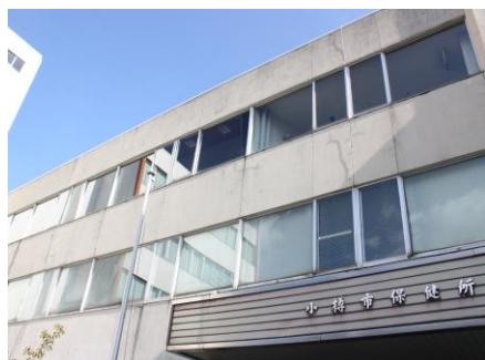
コンクリートのひび割れ、汚れがみられる
