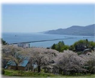
（小樽港北防波堤）
