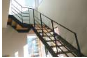
施工例(鉄骨階段 令和4年)
