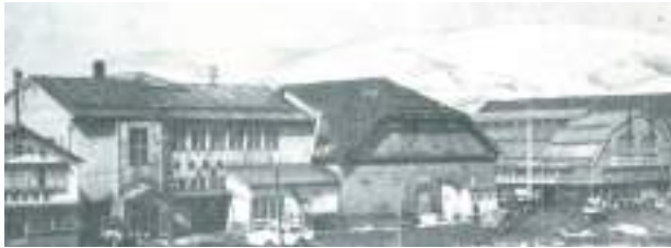
製氷冷凍工場（2階事務所併設）操業開始（昭和28年）
