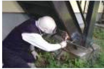
現場作業風景
