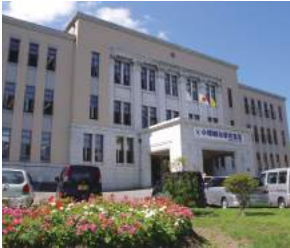
2代目、3代目が手がけた小樽市役所庁舎
