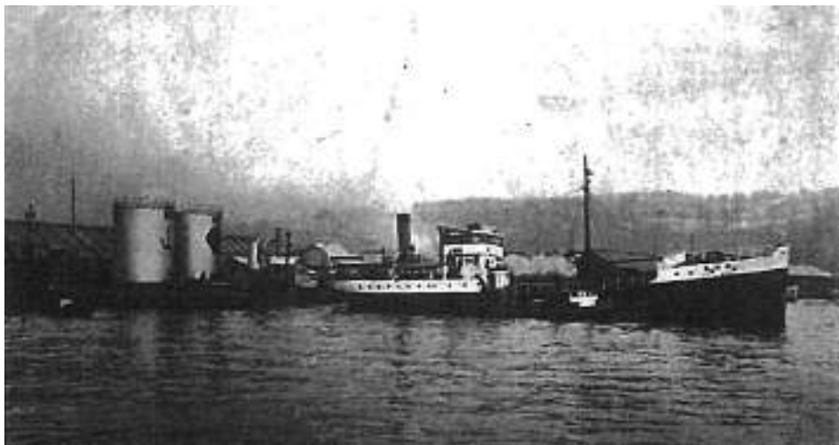
昭和10年に小樽で初めてのA重油タンク(200kl)2本を建設
