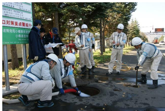
< 緊急時連絡管の運用訓練 >
