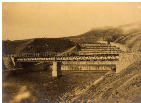
創設当時の階段式溢流路（奥沢水源地）
