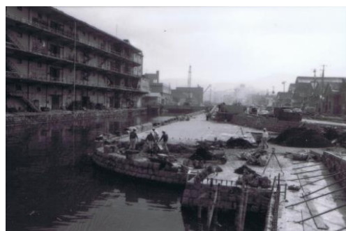
1985年 運河一部埋め立て工事
