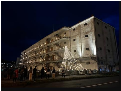
旧北海製罐(株)第3倉庫
