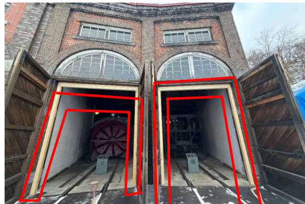
写真④ 機関車庫一号補強後状況
