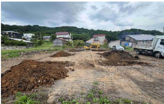
写真③ 埋蔵文化財保護のための試掘調査状況(2)
