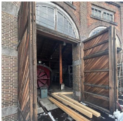
写真③ 機関車庫一号補強工事施工状況
