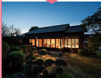
宿泊施設に改修した かつぬく 勝目邸
