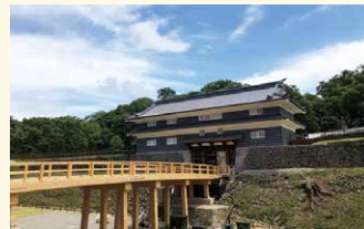
復原された鼠多門、鼠多門橋
