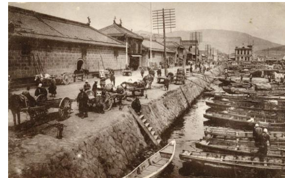
大正中期の小樽運河（物流倉庫が建ち並ぶ）
