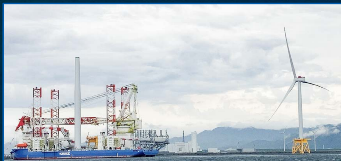
洋上風力発電施設の建設
