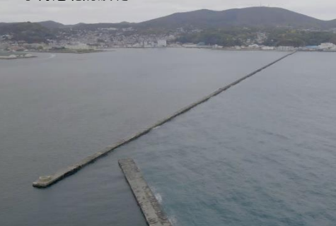
小樽港北防波堤
