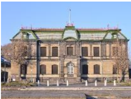
旧日本郵船株式会社小樽支店 (国指定重要文化財)
