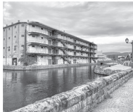
旧北海製缶倉庫棟第3倉庫
