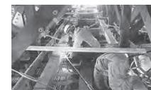
外壁の石材や屋根の小屋根みの内部に新しく補強材を入れ、建物の外観を変えずに、耐震性の向上を図りました。
