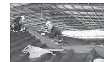
下地に防水シートを新設し、従来の垂鉛引鉄板から、錆びにくく耐用年数が高いガルバリウム鋼板でふき替えました。
