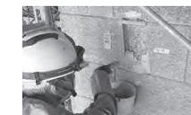
もろくなった部分を削り、小樽軟石等を加工した石材を固定する「張石補修」や石に似せた擬石材を塗る「擬石補修」をしました。
