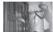
漏水により壁紙の一部が剥がれた貴賓室と会議室では、下地のしっくいを塗り直し、復元した金唐革紙を従来の技法で貼り直しています。
