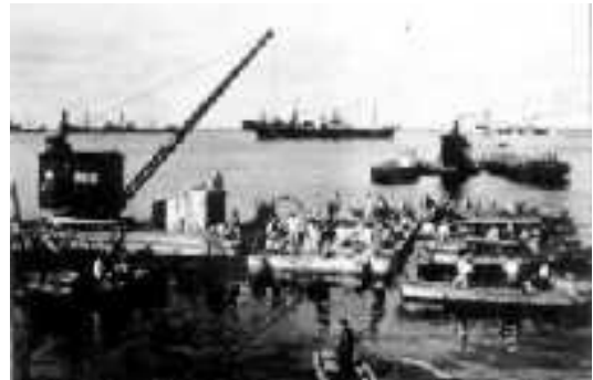
第一号埠頭基部のケーソン
