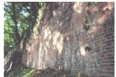
旧手宮鉄道施設の擁壁
