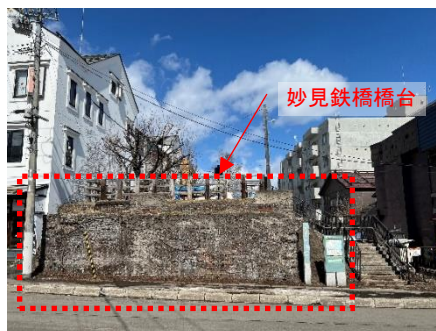
令和 7 年（2025） 妙見鉄橋橋台
