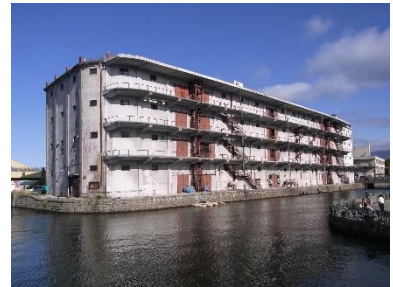
第3倉庫（運河側）
