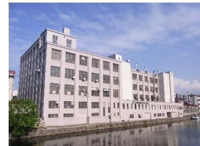
北海製罐倉庫(株)工場棟（運河側）
