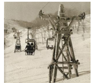
設置間もない頃のリフト (昭和 27 年 3 月)
