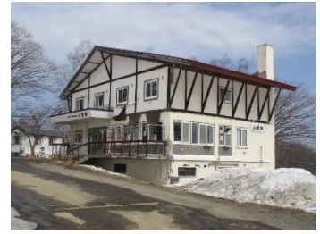
現在の小樽天狗山山麓館
