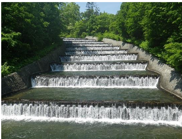
奥沢水源地（階段式溢流路）
