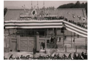
旧小樽区公会堂の上棟式 （明治44年6月24日）
