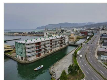
海側の護岸と 旧第3倉庫の外壁
