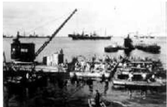
第一号埠頭基部のケーソン
