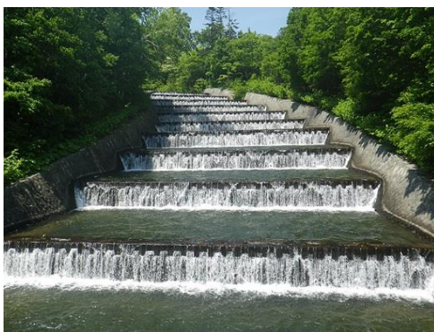
奥沢水源地（階段式溢流路）
