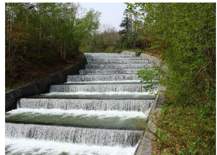
奥沢水源地 階段式溢流路
