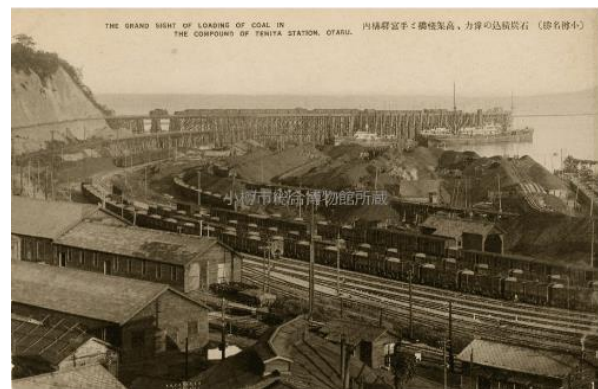
手宮駅構内と高架棧橋
