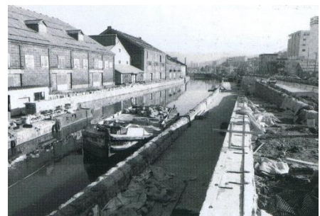
運河一部埋め立て工事
