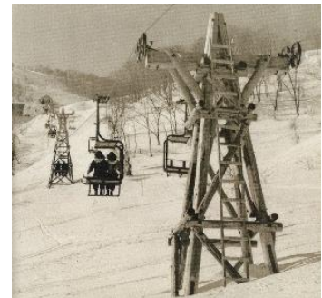
設置間もない頃のリフト (昭和 27 年 3 月)
