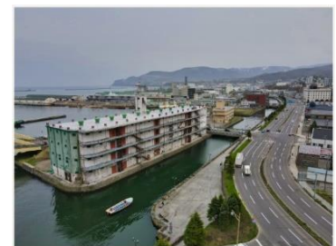
海側の護岸と 旧第3倉庫の外壁
