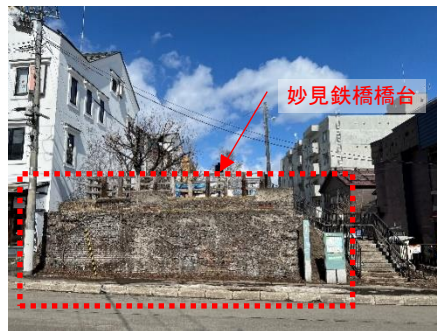
令和7年（2025） 妙見鉄橋橋台
