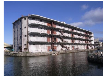
旧第3倉庫 (運河側)
