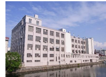
北海製罐倉庫(株)工場棟 (運河側)
