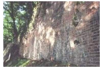
旧手宮鉄道施設の擁壁
