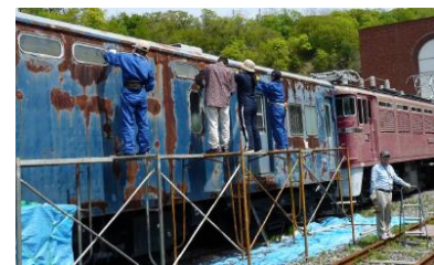
鉄道車両の補修作業
