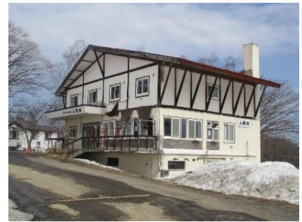
現在の小樽天狗山山麓館
