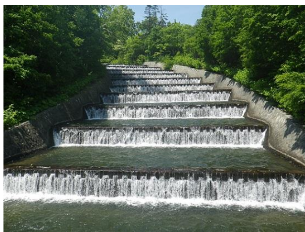
奥沢水源地（階段式溢流路）
