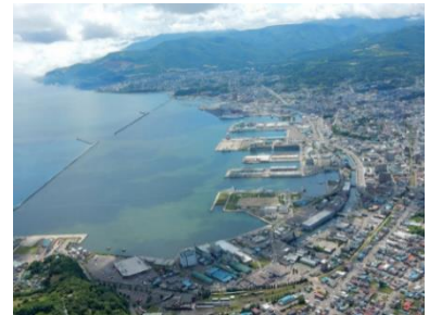
小樽港の防波堤
