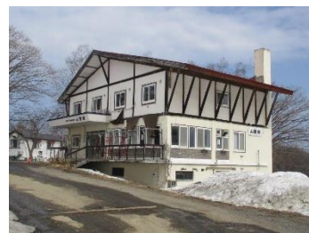
現在の小樽天狗山山麓館
