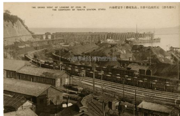
手宮駅構内と高架棧橋
