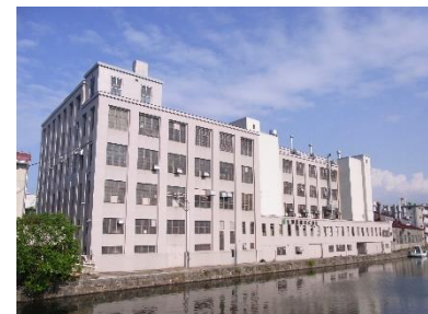
北海製罐倉庫(株)工場棟（運河側）
