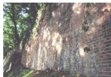
旧手宮鉄道施設の擁壁
