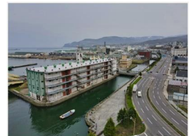
海側の護岸と 旧第3倉庫の外壁
