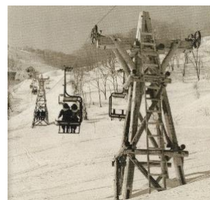
設置間もない頃のリフト (昭和 27 年 3 月)
