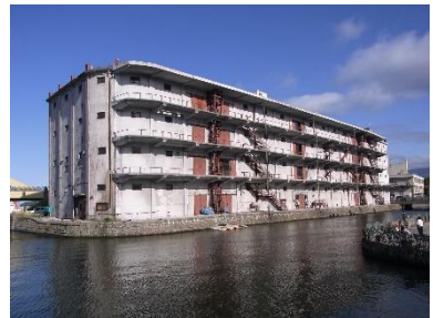
旧第3倉庫（運河側）
