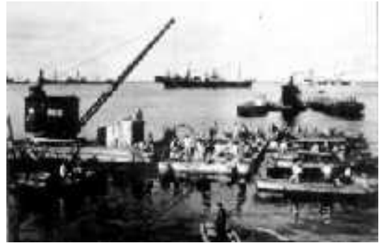
第一号埠頭基部のケーソン
