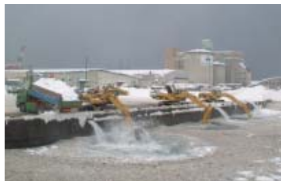
(中央ふ頭基部における雪処理の状況)
