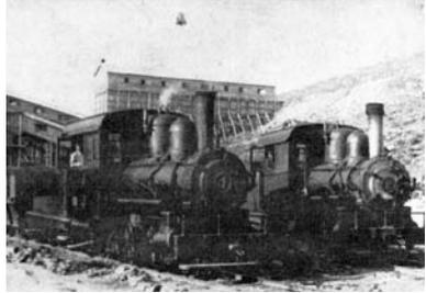
昭和11年 小樽の橋本鉄工所で造られた森林鉄道用蒸気機関車（小樽鉄工組合「創立40周年記念誌」より）
