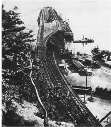
石炭を積み込むために手宮に建設された棧橋（写真提供／小樽市総合博物館）
